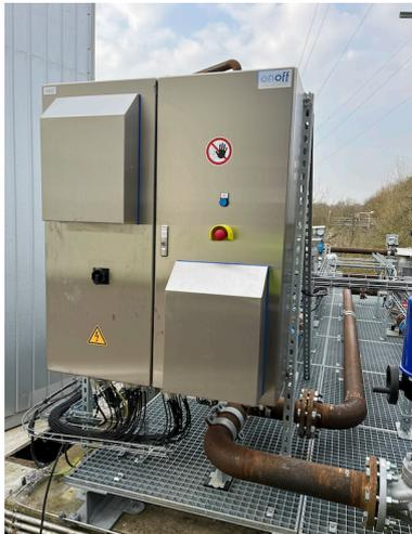
onoff automation services gmbh übernahm unter anderem den Bau und die Montage des Vor-Ort-Steuerschanks für den Außenbereich.
